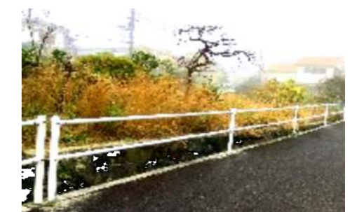
(危険な水路に設置されたガードパイプ)
