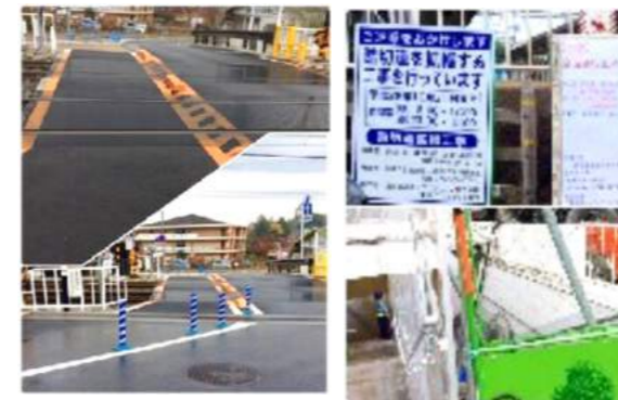
(竣工した歩道と南北通路のエレベーター工事現場)
