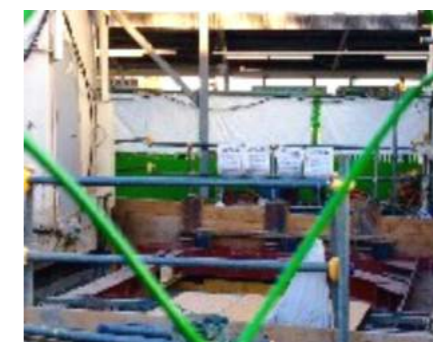
(22.12.15) (エレベーターの設置工事現場)
