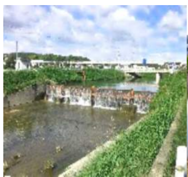
(改修予定の富雄川の源代井堰)
