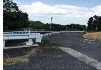
佐保台西町 鹿川側道陥没改修
