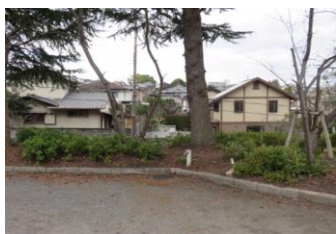
平城3号公園 排水改修
