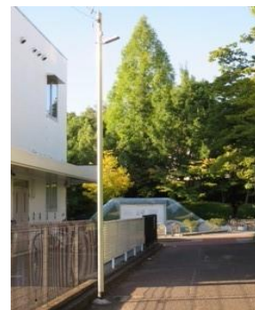
駅前団地横の歩道の 街灯新設
