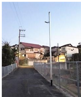
学園朝日町 街灯新設
