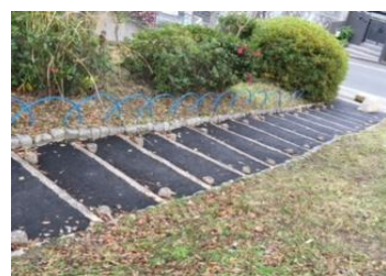
朱雀 5 丁目公園 水はけ・段差解消
