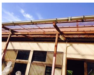
朱雀バンビーホームの 屋根・波板の交換
