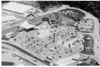
針テラス全景
