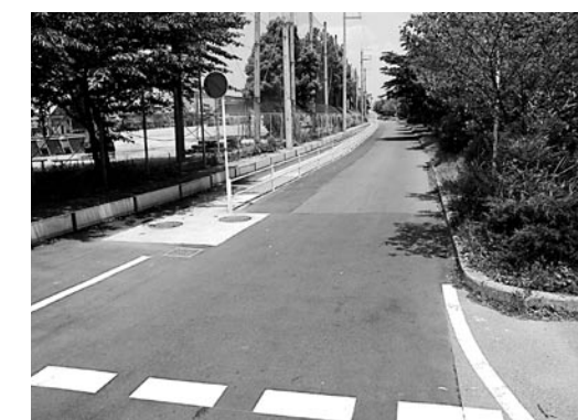
■ 市道中部675号線の一部拡幅 三笠中学校東側付近 (H20.2. 完成)
