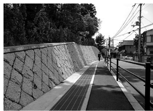
■ 市道中部51号線歩道の改修 山陵町付近一部完成
