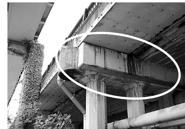
■ 鶴舞橋落橋防止 (橋足工事 12箇所 H20.3.21 年完了)
