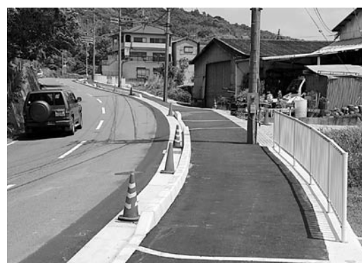
■ 白毫寺地域の歩道設置 (県道 奈良・名張線) (H20.6. 完成予定)
