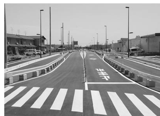
■ 大和中央道菅原工区 (H20.5. 一部共用開始)
