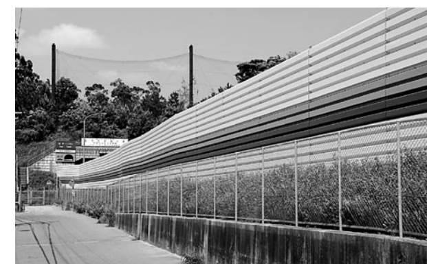
■ 第2阪奈道路遮音壁 (H20年完成) (宝来トンネルの出入口付近100m区間)
